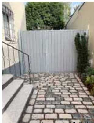
Zugang zum Innenhof-Fahrrad- Stellplatz
