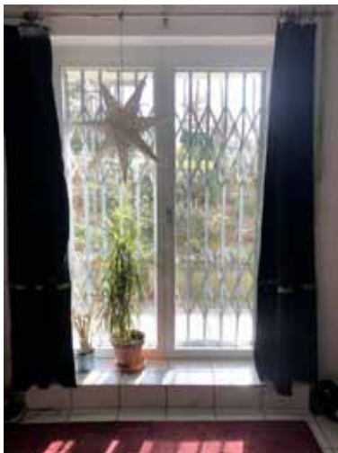
Sout.Terrasse-Sicherh.-Gitter, schließ- +schiebbar
